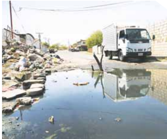
Vecinos temen a enfermarse debido al desborde de aguas negras. Foto: Karla Torres
