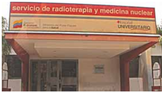
Los aires acondicionados de la Unidad de Radioterapia tienen dos semanas fuera de funcionamiento por la falla en una brequera. Foto: Alejandro Paredes
